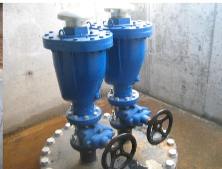
Instalación de dos ventosas para un punto crítico en la conducción
