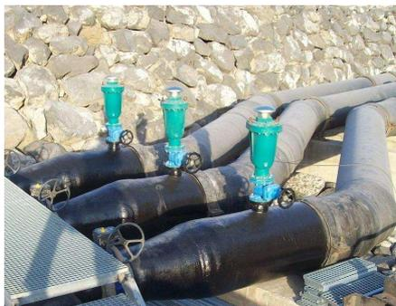
Ventosas Universales trifuncionales con sistema de levas en una instalación de bombeo con tratamiento especial de pintura para intemperie
